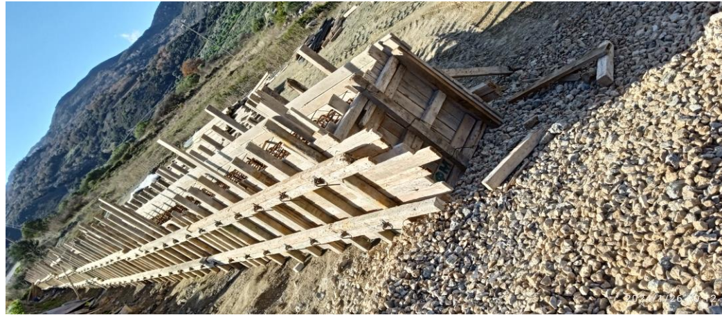
ΑΠΟΚΑΤΑΣΤΑΣΗ ΖΗΜΙΩΝ ΣΤΟ ΔΡΟΜΟ ΡΕΘΥΜΝΟ - ΣΠΗΛΙ
